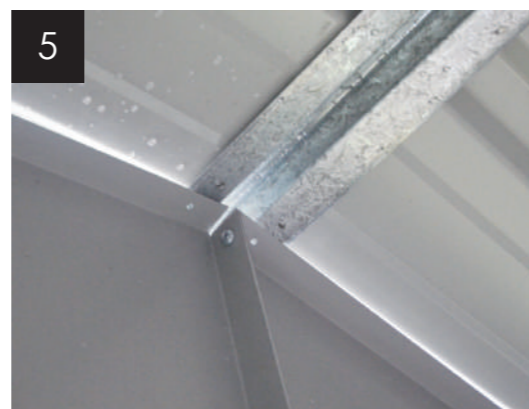
5: まず表側の各隅のビス止めを行ってから、他の箇所のビスを止めていきます。
