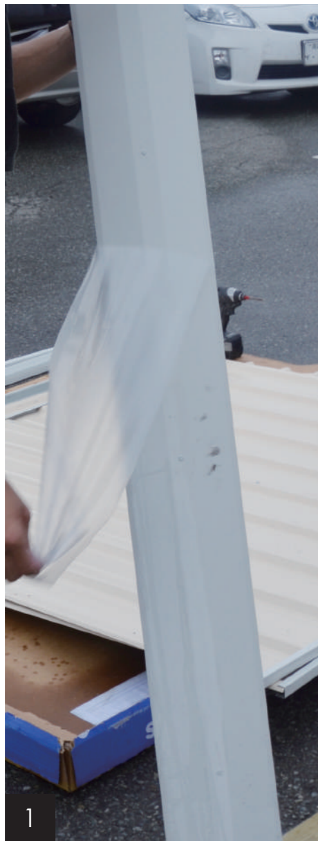
1: リッジビームや妻壁には保護シールが貼ってあります。作業をするときは、まず保護シールを剥がしてから取り付けを行いましょう。
