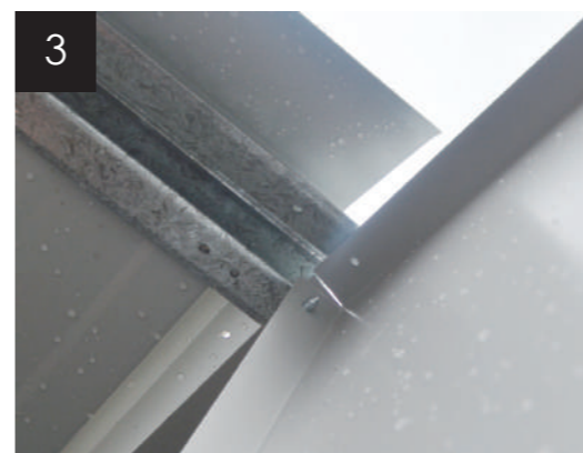
3: リッジビームを取り付けた方の屋根パネルを先に本体パネルに乗せます。
