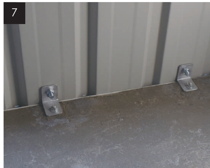
7:コンクリート床用のアンカー類です。アンカーボルトなどの部材が必要な本数入っています。
